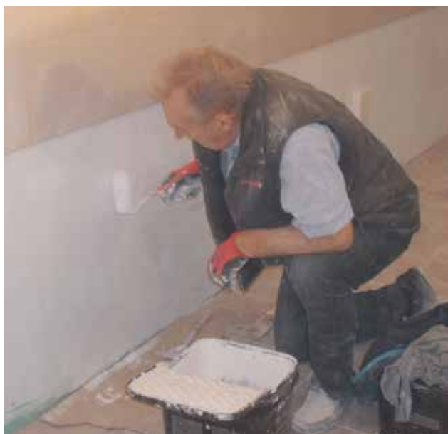
Podczas remontu – fot. B. Belter
