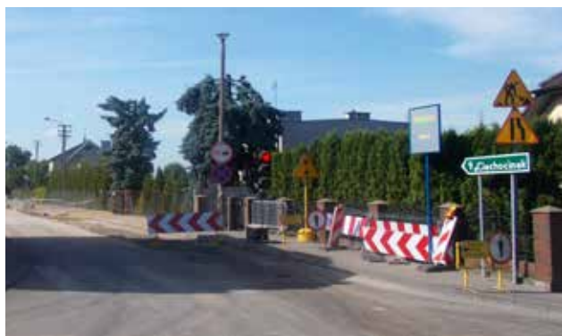
Początek remontu – fot. B. Belter
