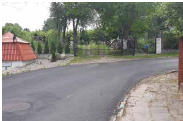
Nowa nawierzchnia na ul. Browarnej – fot. B. Belter
